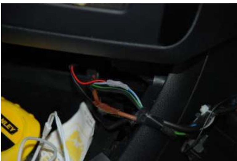
Il punto di prelievo di positivo illuminazione e negativo, sulla presa 12 Volt del tunnel centrale
